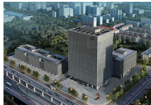
▲有研科技创新中心建设项目主体结构封顶
